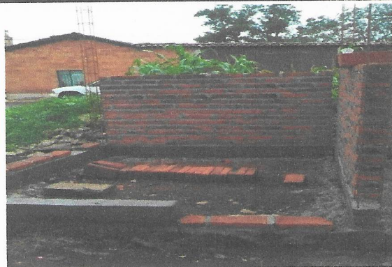
CONSTRUCCIÓN DEL COMEDOR EN EL JARDÍN DE NIÑOS EN LA LOCALIDAD DE AGOSTADERO (PROCESO)
